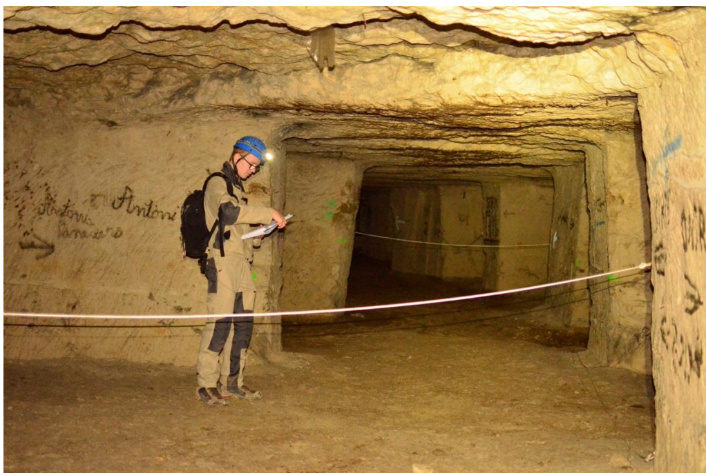
Illustration 7 : Paysage typique de la carrière de Loissail, exploitée selon la technique des chambres et piliers tournés. La géométrie rectiligne est classique d'une exploitation de moellons pour la pierre de taille
