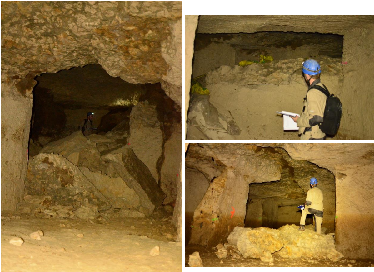
Illustration 9 : Chutes de toit « récentes », probablement post-exploitation, associées à des diaclases naturelles argilisées
